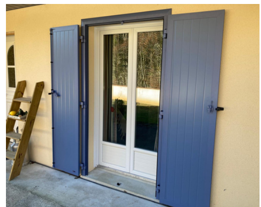
Gonds en tableau Pose à l'intérieur du tableau
